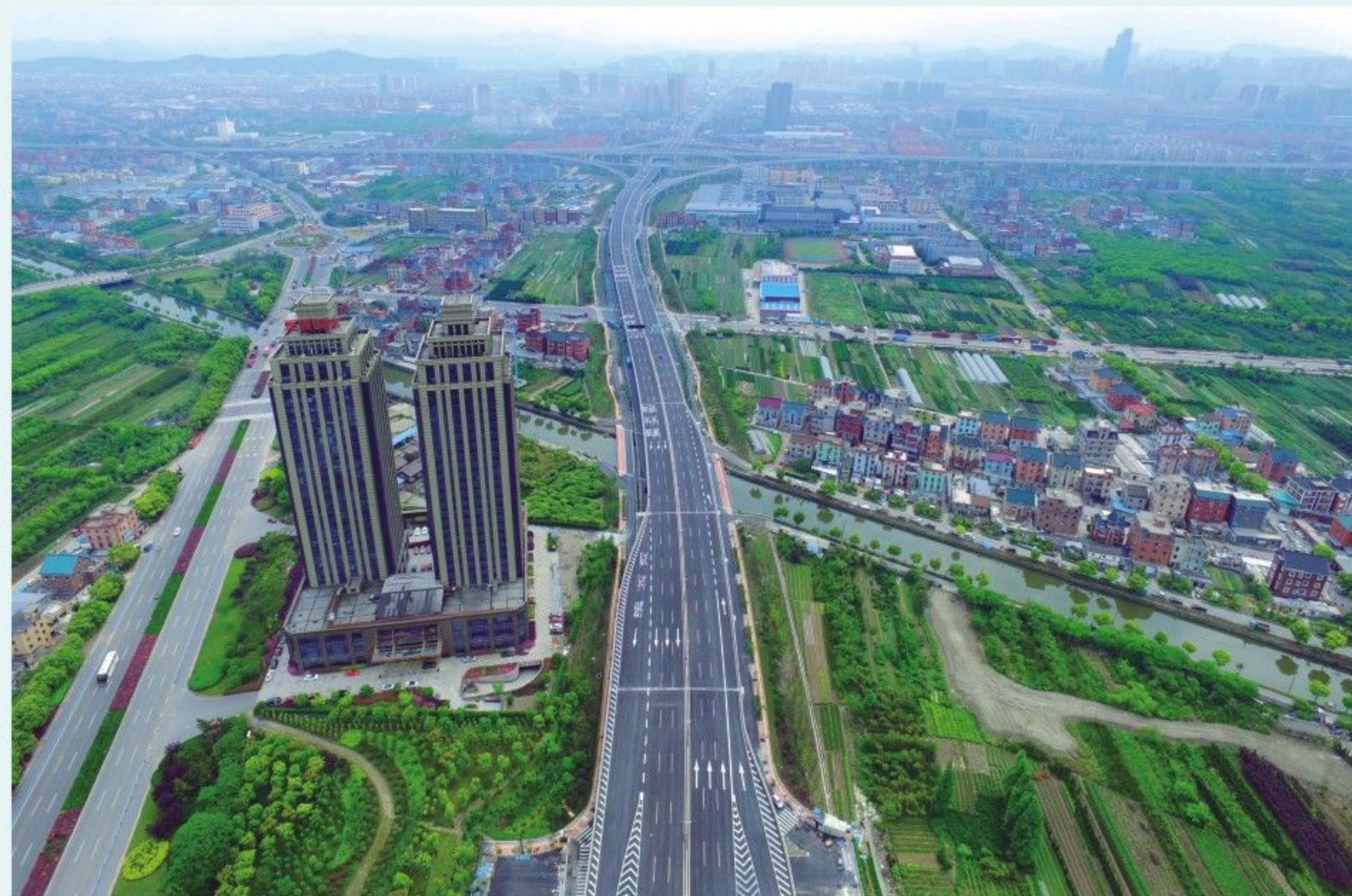
▲ 九堡大桥南接线工程
