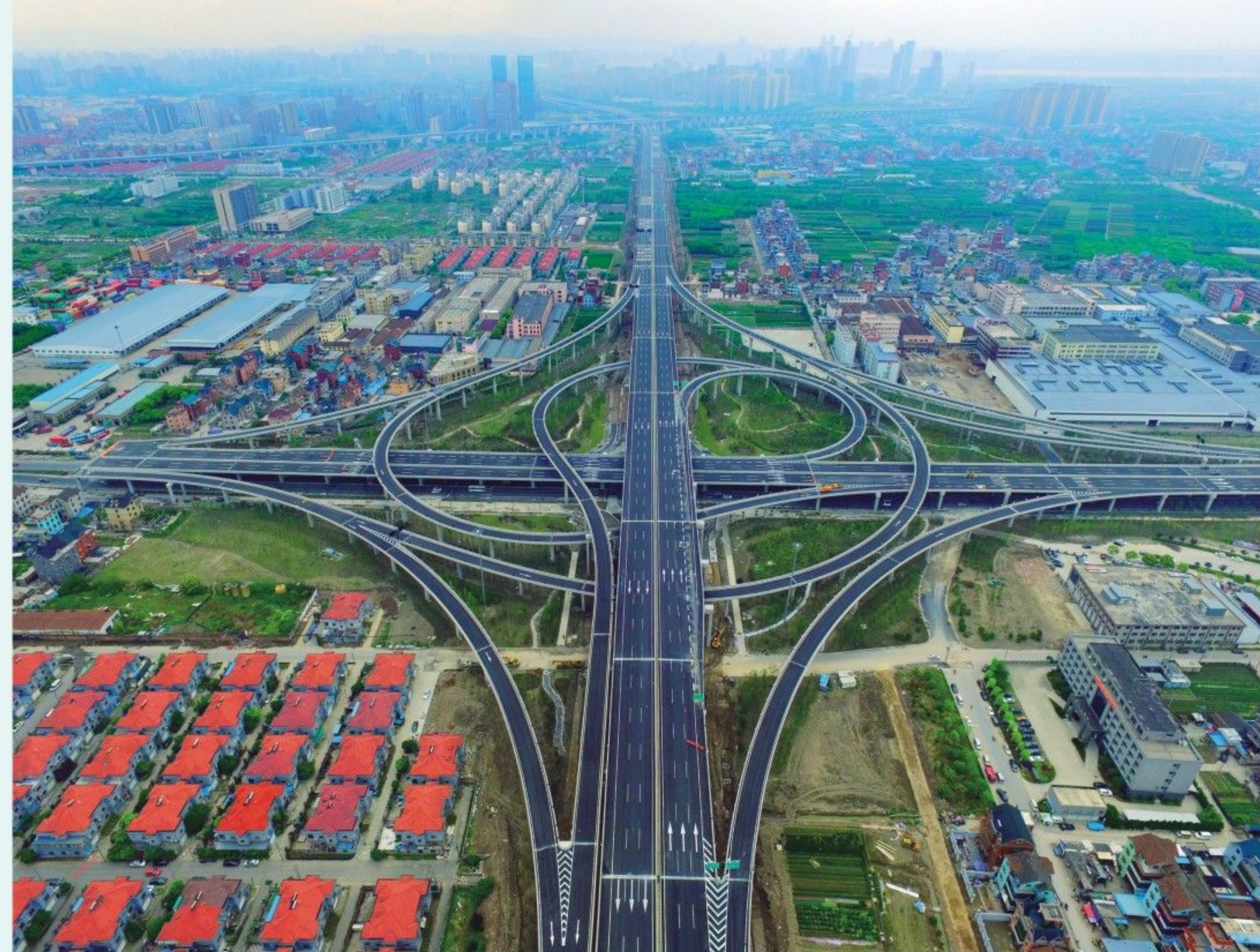
▲ 九堡大桥南接线工程-机场高速互通节点
